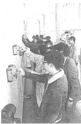
電磁波レーダーで壁内の配筋状態などを検査する学生たち
