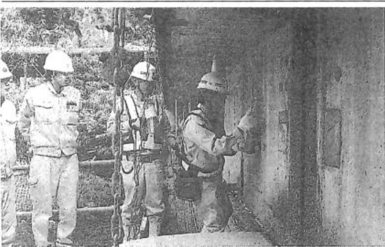
非破壊検査実習に取り組む参加者＝大野市荒島橋
