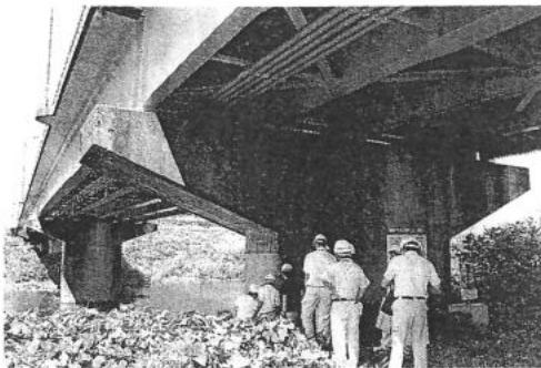
橋脚や床版など健全性をチェックする参加者たち＝福井市板垣橋
