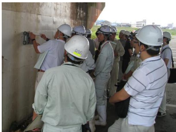
写真-6 自治体職員向けの橋梁点検研修
