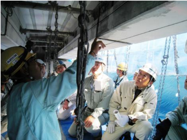
写真-2 現場見学会(河野大橋電気防食工事)
