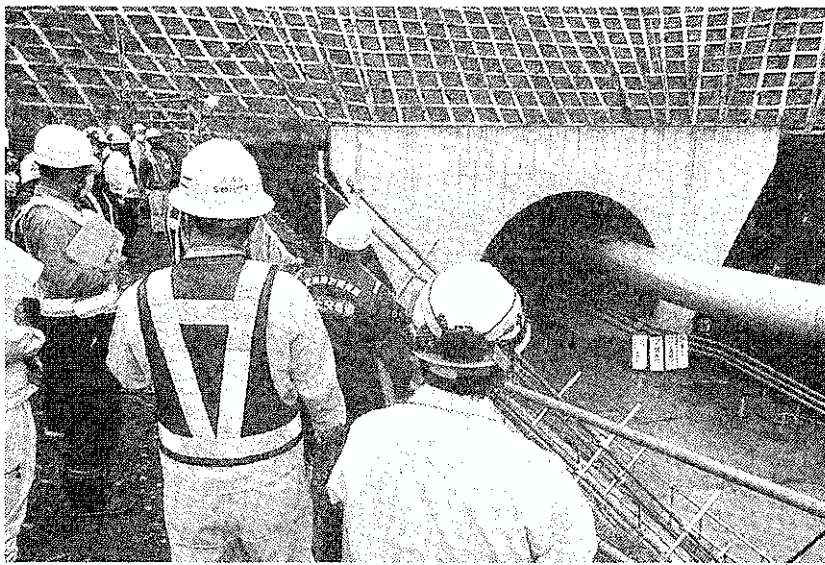
水海川導水トンネルの下流側入口を見学
