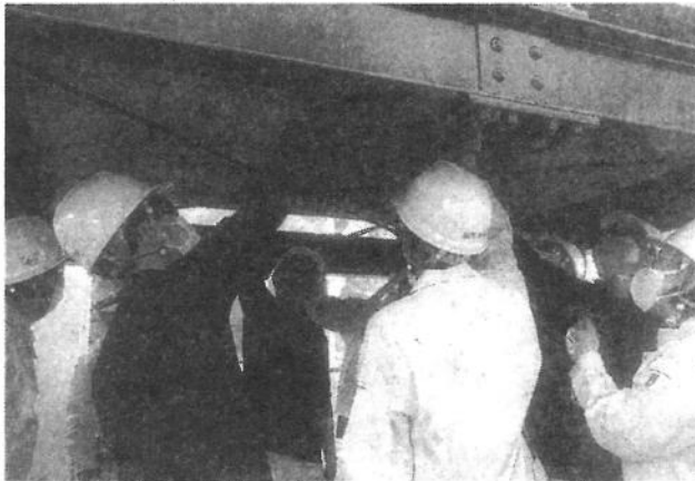
ハンマーを用いた打音、ひびわれ調査実習の様子
